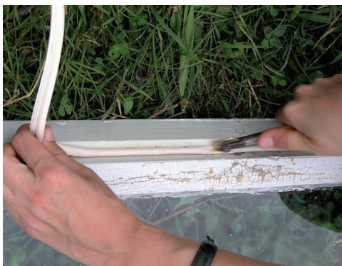
Встановлення ізоляції
